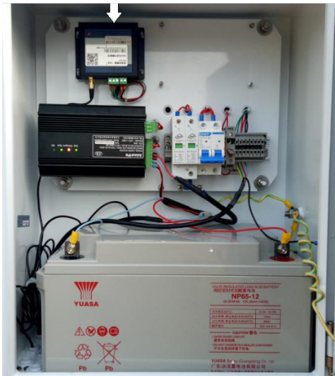
图 1-8 HY101N 数据采集器在机箱内的安装位置
